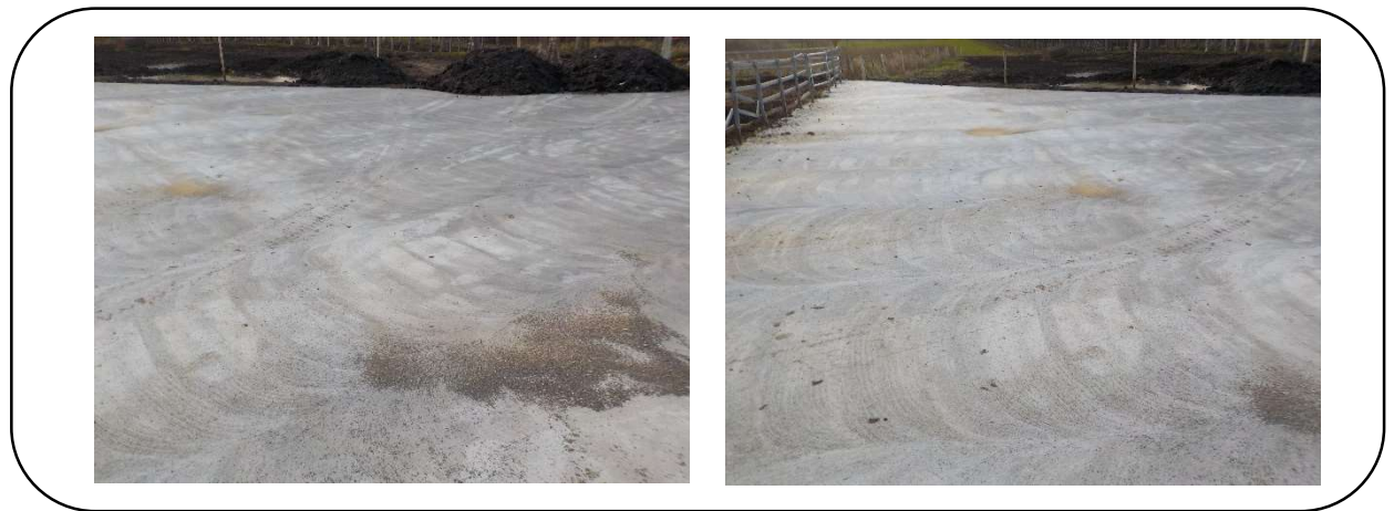
図2 堆肥盤補修完了
