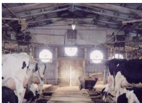
写真1 常時、換気扇をゆっくり回して排気する
