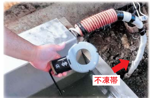
不凍帯をホースに巻き、電熱線を水槽に入れる
