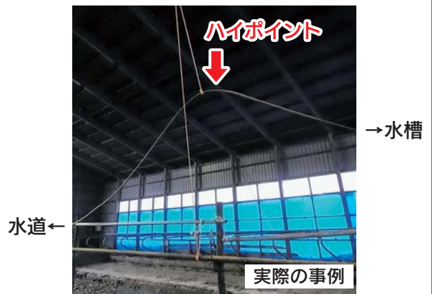
不凍帯をホースに巻き、電熱線を水槽に入れる
