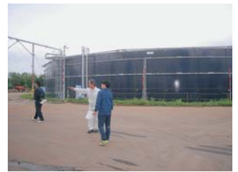
バイオガスプラントでの見学
