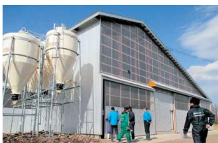
昨年完成した乾乳舎
