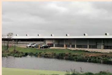
強制換気の大ベンチレーター
