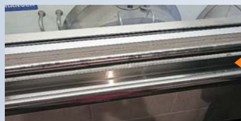
手ずりが生乳の流るパイプライン
