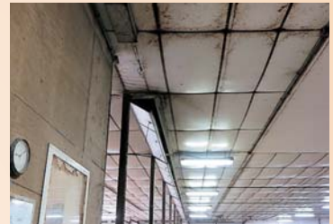
屋根裏からの入気口
