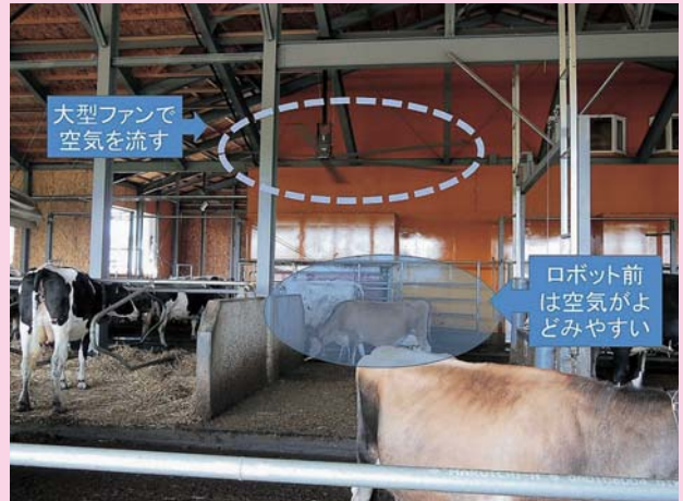
写真1 搾乳ロボット前の空気を動かす
