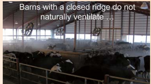
①自然換気が機能せずもやがかかった状態
