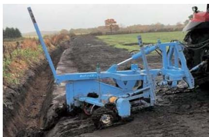
写真1 ①明きょと②カットソイラーの施工
