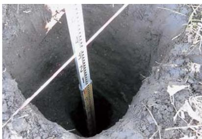
写真2 ③縦孔暗きょの施工
