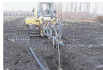
写真4 カッティングドレーン施工
