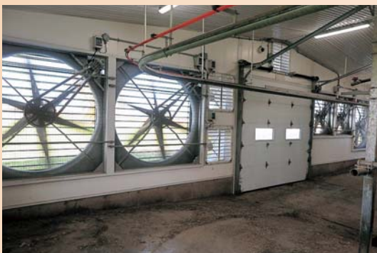
換気は強制のトンネル換気にて牛床が乾いていました
