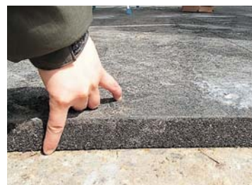
写真 底冷え対策でマットを敷設
